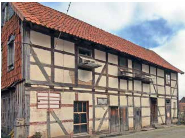
Scheune Alte Dorfstraße 5
